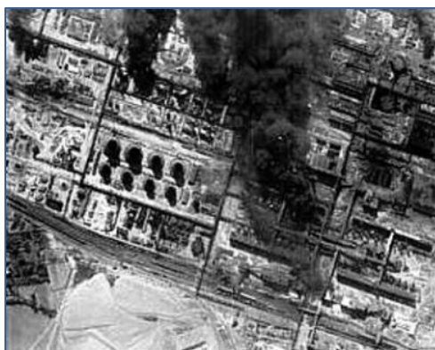
Pohled na hořící STW AG.
