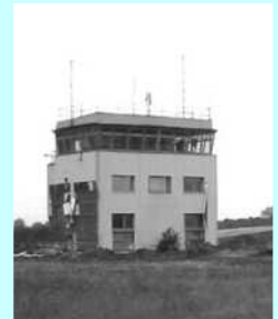
Věž, pracoviště ŘL, dispečérů a meteorikářů
